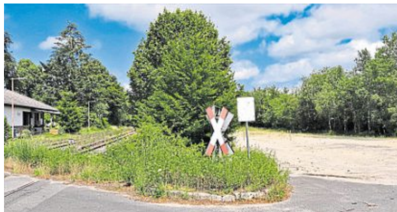
Am Ellerner Bahnhof gibt es einen möglichen Frachtschlagplatz, der unmittelbar am ehemaligen Ladegleis genügend Platz böte.
