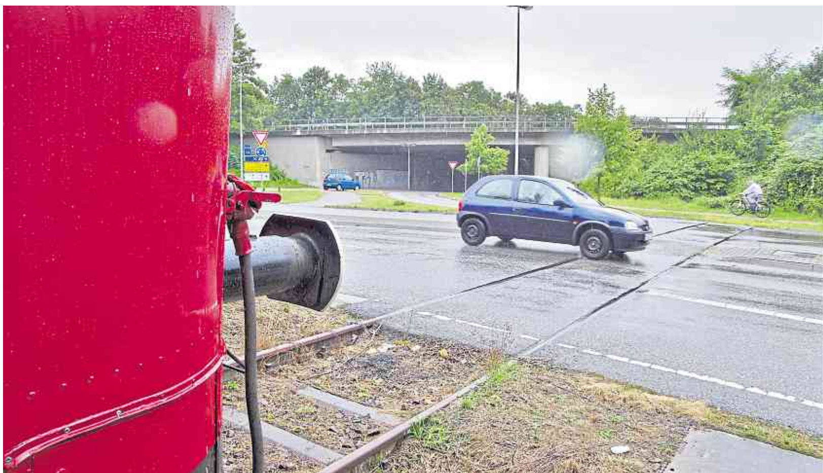
An der Brauereistraße gibt es kein Durchkommen für die Brexbachtalbahn. Denn hier wurden die Schienen der stillgelegten Strecke überbaut, um eine Ortsumgehungsstraße zu bauen. Doch ist die Stadt vielleicht sogar verpflichtet hier eine Kreuzung zu schaffen?
