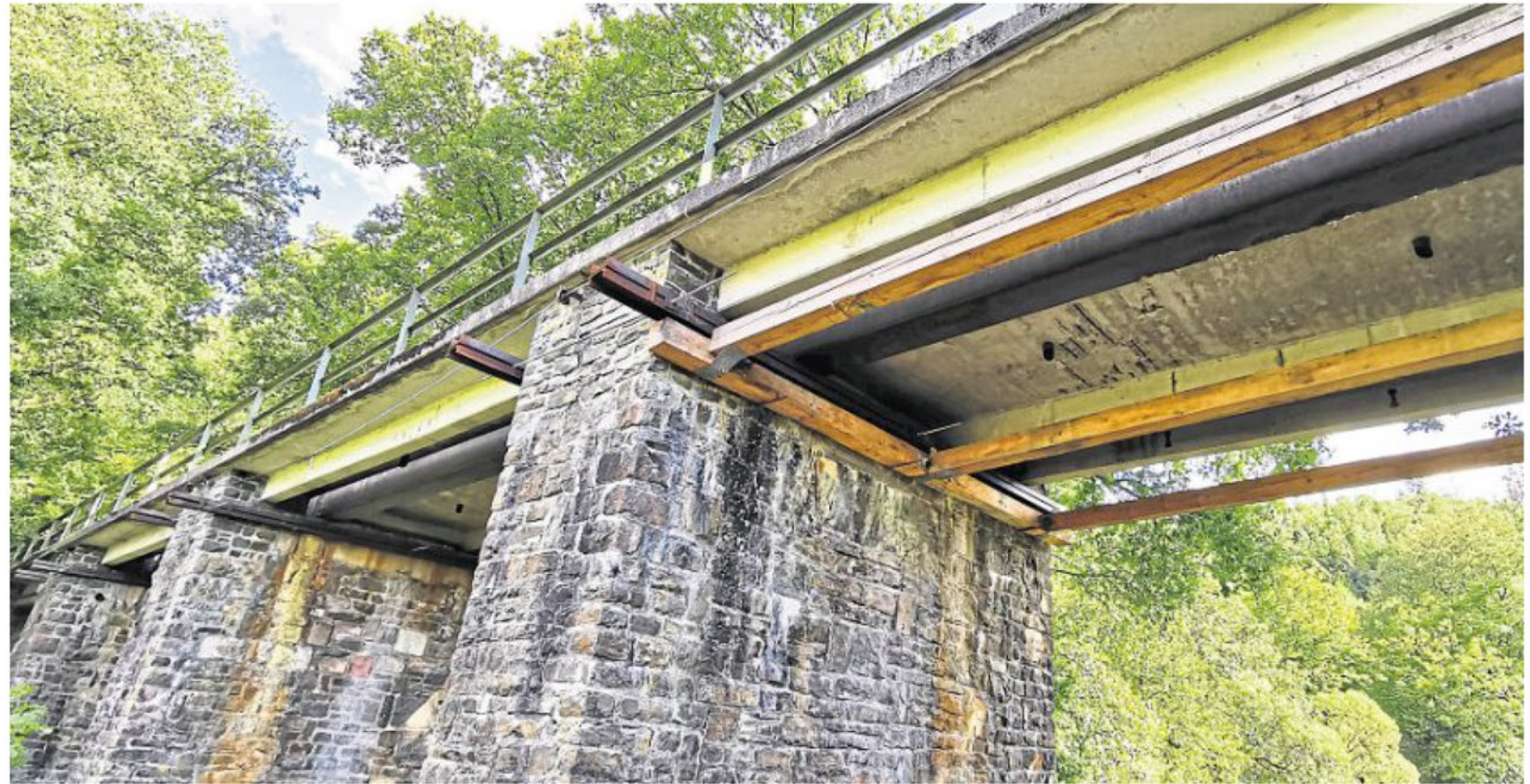
Im Bereich der Gemeinde Seifen müssen drei Brücken ertüchtigt werden. Zwischen Bahnhof und Tunnel liegt das längste Bauwerk (37,5 Meter). Die Nachkriegskonstruktionen waren 2017 von der Westerwaldbahn nochmals stabilisiert worden. Eine Refinanzierung durch Fördermittel scheiterte an der Entscheidung des Altenkirchener Kreistags zur Aufgabe des Güterverkehrs und Stilllegung der Strecke.
