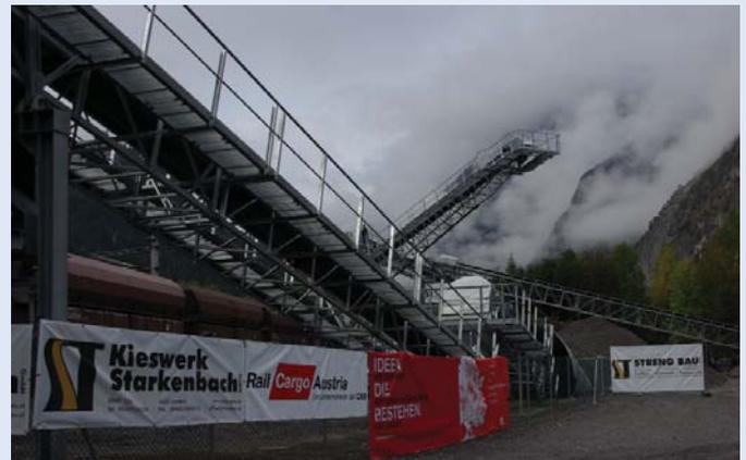
Gleisanlage von 300 auf 600 Meter verdoppelt, um das Aufstellen eines ganzen Zuges mit bis zu 18 Waggons zu ermöglichen. Ebenso erneuert und erweitert wurde die Förderanlage, welche das Abbaumaterial vom Kieswerk im Ortsteil Starkenbach auf dem kürzesten Weg unter der Autobahn A12 durch, über den Innfluss hinweg in die An-
