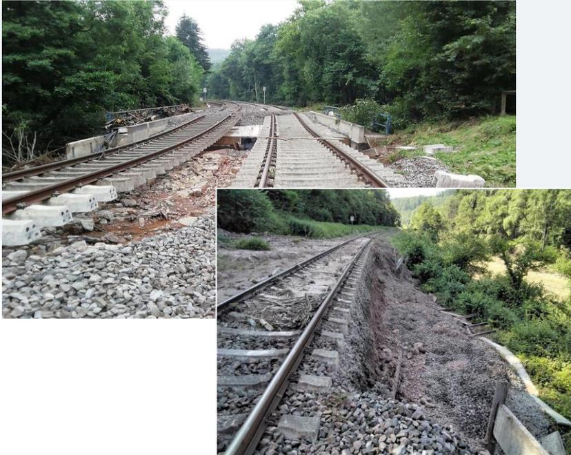
Auf **50 km** Länge wurde der **Oberbau** beschädigt
